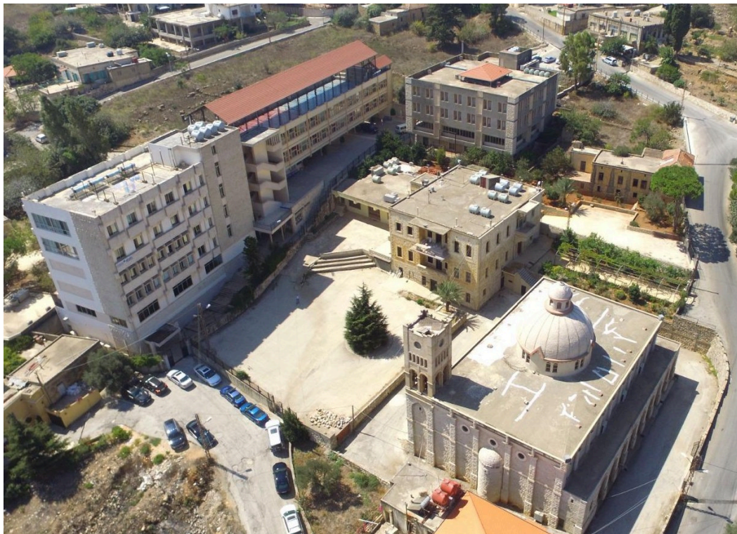
Vue aérienne de l'école
