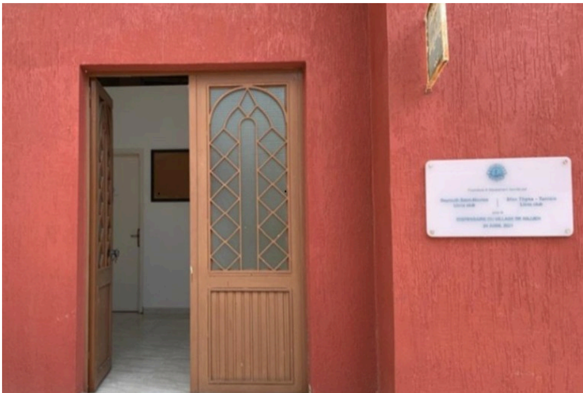
L'entrée du dispensaire de Hajjah - Sud Liban
